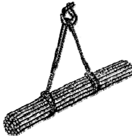
Строповка подтоварника универсальными стропами
